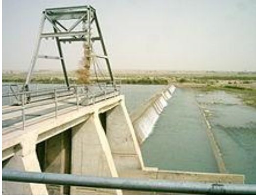
سد نروگاه آبی بند گریشک
