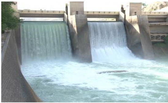
پروژه حیاتی بند سلما
